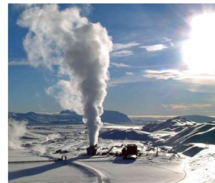
Geotermisk energianlegg i Krafla
