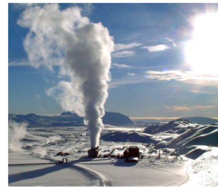
Geotermisk energianlegg i Krafla
